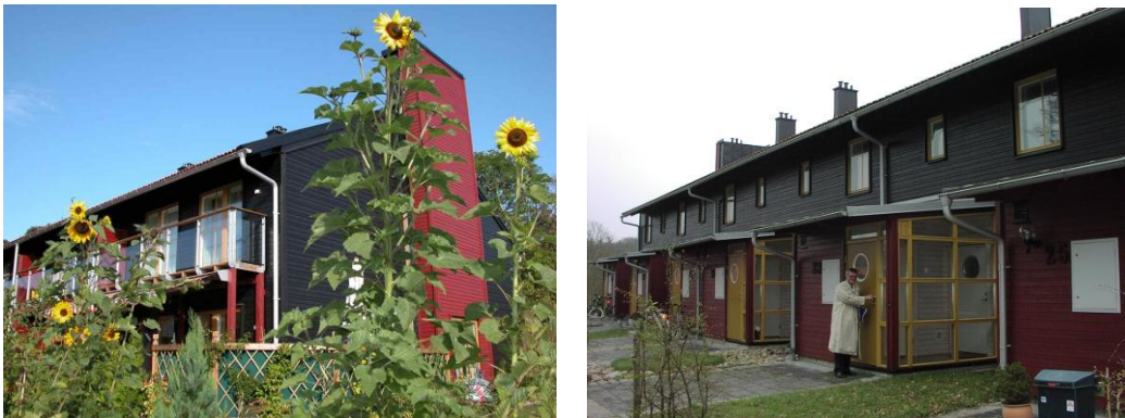
Figur 1 Lindåshusens söderfasad respektive norrfasad. Norrfasadens entré är försedd med ett vindfång.
