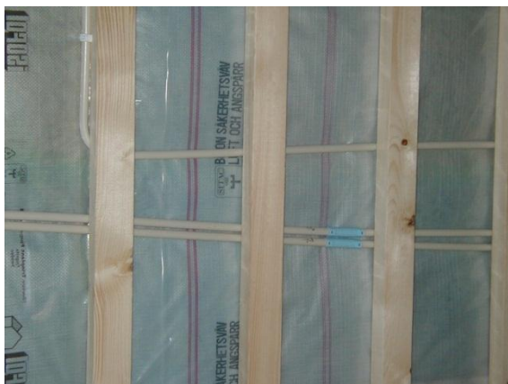
Figur 14 Eldragningar på insidan av lufttätande skiktet. Foto: Peab.
