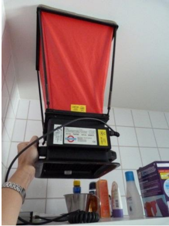
Figur 11 Flödesmätning av frånluftsdon i badrum.
