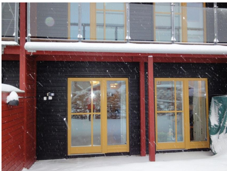
Figur 13 Balkongkonstruktionen är utformad så att lufttättheten är god i klimatskalet.
