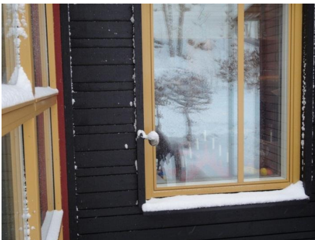
Figur 20 Mätpunkt mot norr är placerad invid köksfönster.
