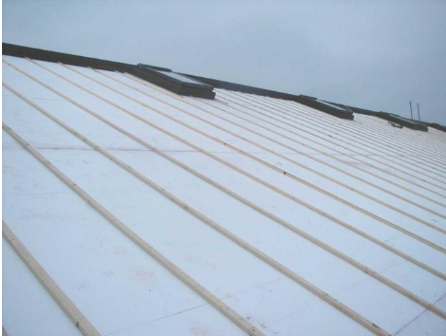
Figur 19 Utvändigt isolerat underlagstak ökar fuktsäkerheten. Foto: Peab.
