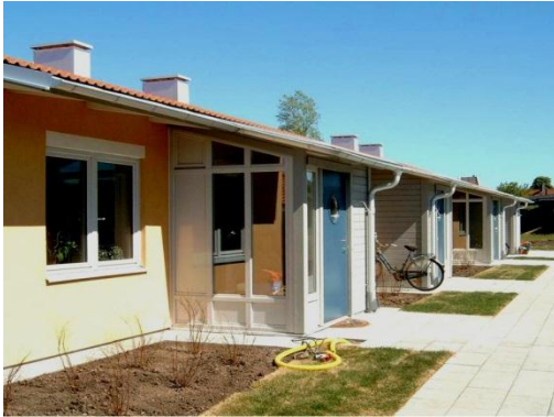
Figur 2 Kvarteret Nornan i Glumslöv är ett exempel på lufttäta och energieffektiva hus. Foto: Karin Adalberth, prime project AB.
