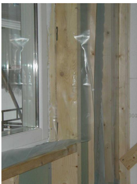
Figur 15 Lufttätande lösning runt fönster med plastfolie, fogmassa. Foto: Peab.
