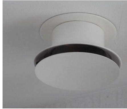
Figur 8 Tilluftsdon i Lindås.
