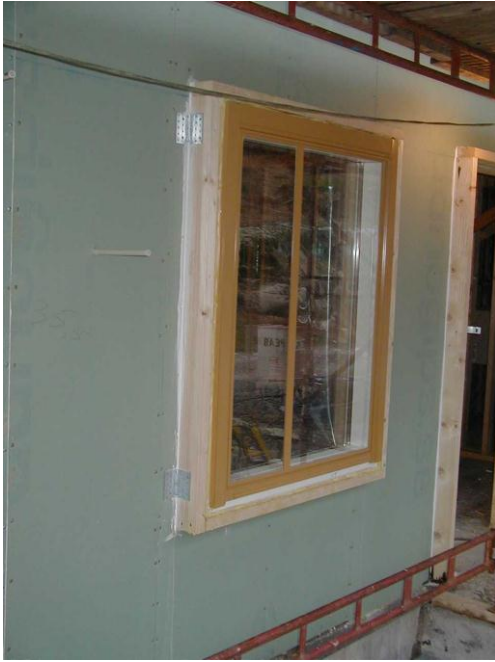
Figur 23 Utegips för cellplasten monteras på plats. Foto: Peab.
