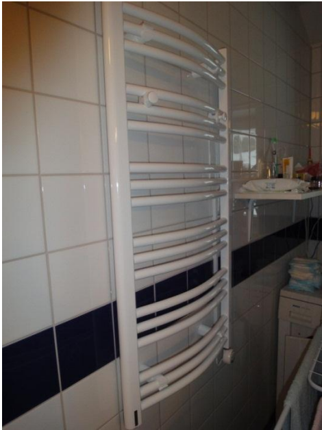
Figur 6 Handdukestorkar används i flera av radhusen som en extra värmekälla.
