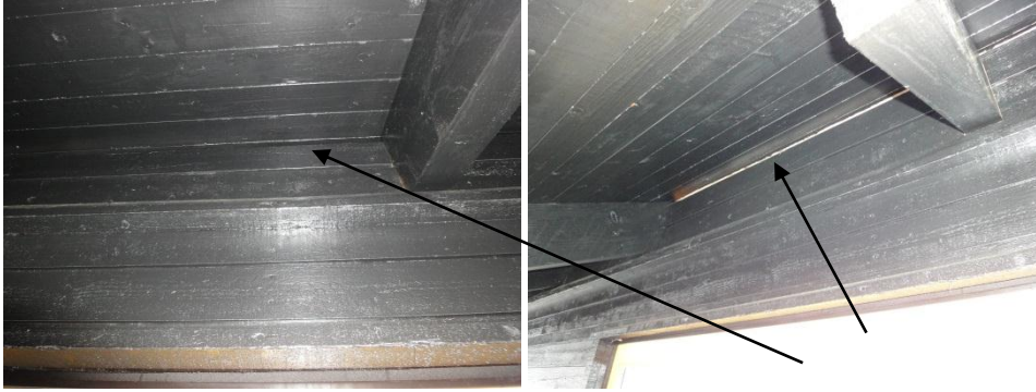
Figur 21 Takfotens utformning där luftspalten in mot tak finns vid pil (Lindåshusen).
