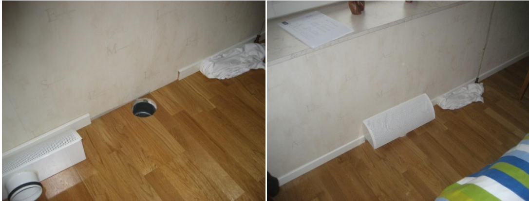
Figur 44 Tilluftskanalen i sovrummet med och utan don.
