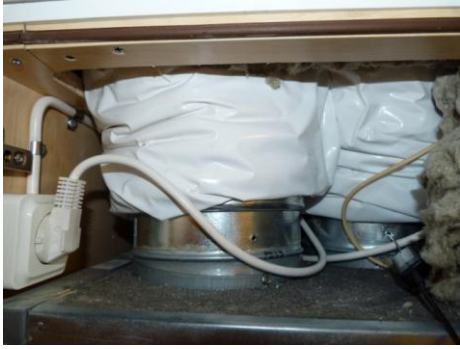
Figur 12 Temperaturmätning av till- och frånlufts kanal.
